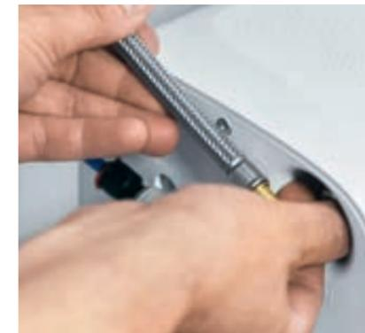
Schließen Sie die Schläuche an die Armatur und den Kühler an. Öffnen Sie anschließend die Eckventile, bevor Sie das Gerät an den Stromkreislauf anschließen.
