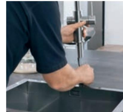
Platzieren Sie die Armatur und fixieren Sie diese von unten mithilfe des Befestigungssets.
