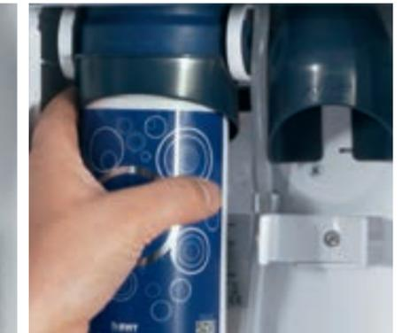
Drehen Sie den Filter in den Filterkopf und setzen Sie den Kühler im Küchenunterschrank in die gebohrte Abluftöffnung.
