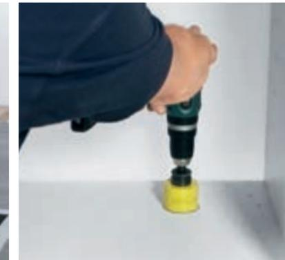
Fixieren Sie die Bohrschablone im Unterschrank und bohren Sie mittels Lochsäge die Abluftöffnung.
