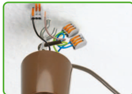
Zapojení vodičů pro připojení osvětlení.
