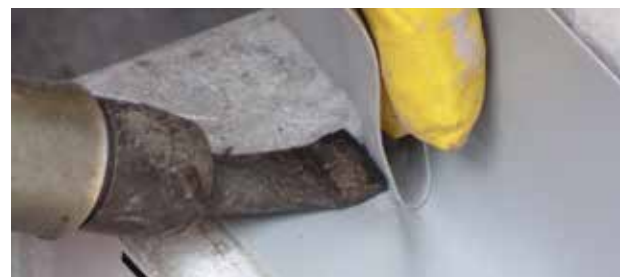
4. Verbinden des Sikadur Combiflex® Bandes durch Schweißen
