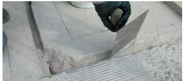
2. Aufbringen des Grundauftrages
