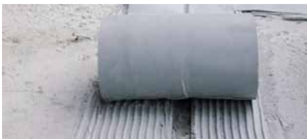
3. Einbringen des Sikadur Combiflex® Systemklebers
