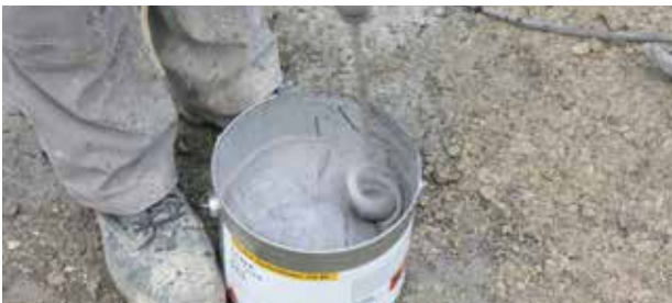
1. Anmischen des Sikadur Combiflex® Systemklebers
