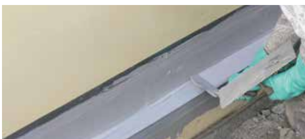
5. Aufbringen des Deckauftrages
