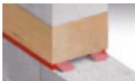
Spáry mezi stěnou a dřevěným trámem
