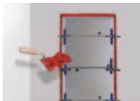
Zdění protipožárních dveří
