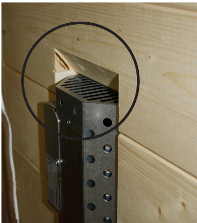
Abb. 1: Lüftungsschlitze freilassen
