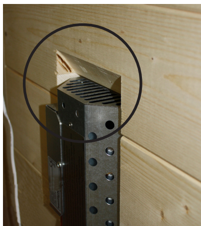
Fig. 1 : Ne pas couvrir les fentes d'aération
