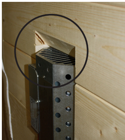
Fig. 1: Não tapar as aberturas de ventilação
