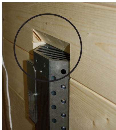
Рис. 1. Освободить вентиляционные отверстия
